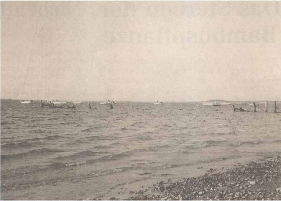
Das Bild rechts stammt aus dem Pressebericht und zeigt die Reste der zerstörten Brücke und den kleinsten Teil des Bojenfeldes.
